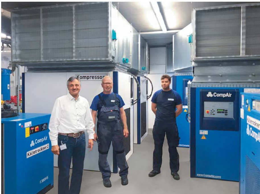
Abb. 3: Josef Friedl, Geschäftsführer der A&F Drucklufttechnik (links), projektierte eine Ergänzung der Druckluftstation um einen weiteren drehzahlgeregelten Schraubenkompressor der Typenreihe D75H RS.
